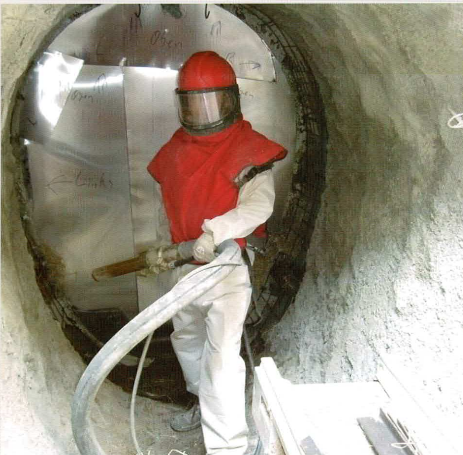
Einbau Spritzbeton
